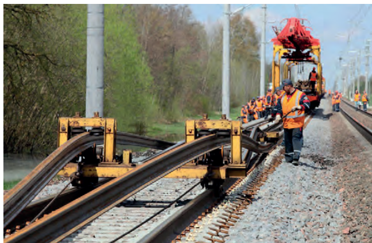
Рис. 4. Укладка плетей бесстыкового пути
