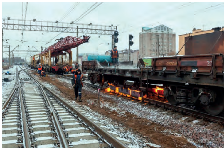
Рис. 6. Нагрев рельсовых плетей установкой инженера Зубова «Змей Горыныч»
